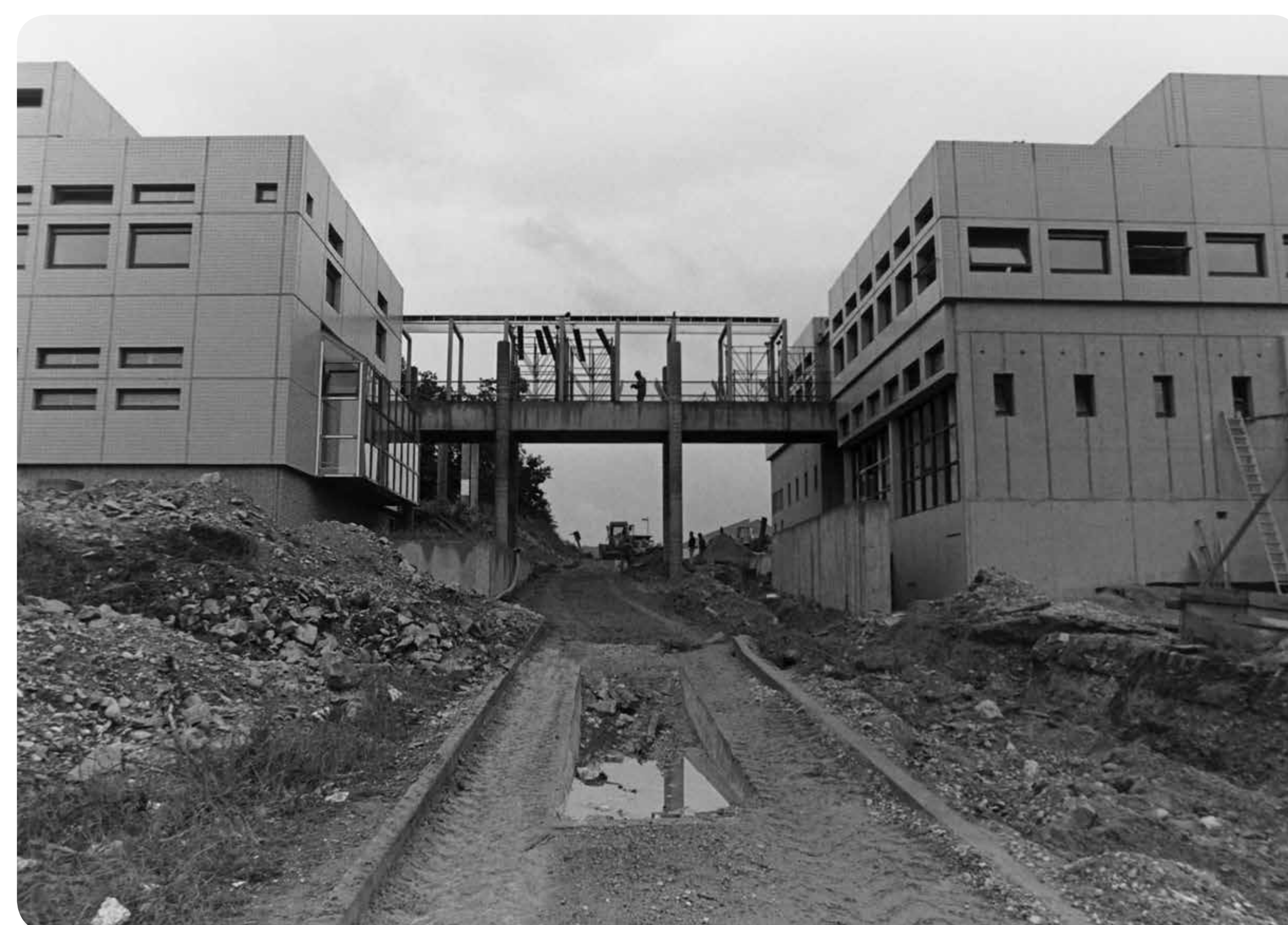
➤ Construction de la passerelle, vue de dessous
