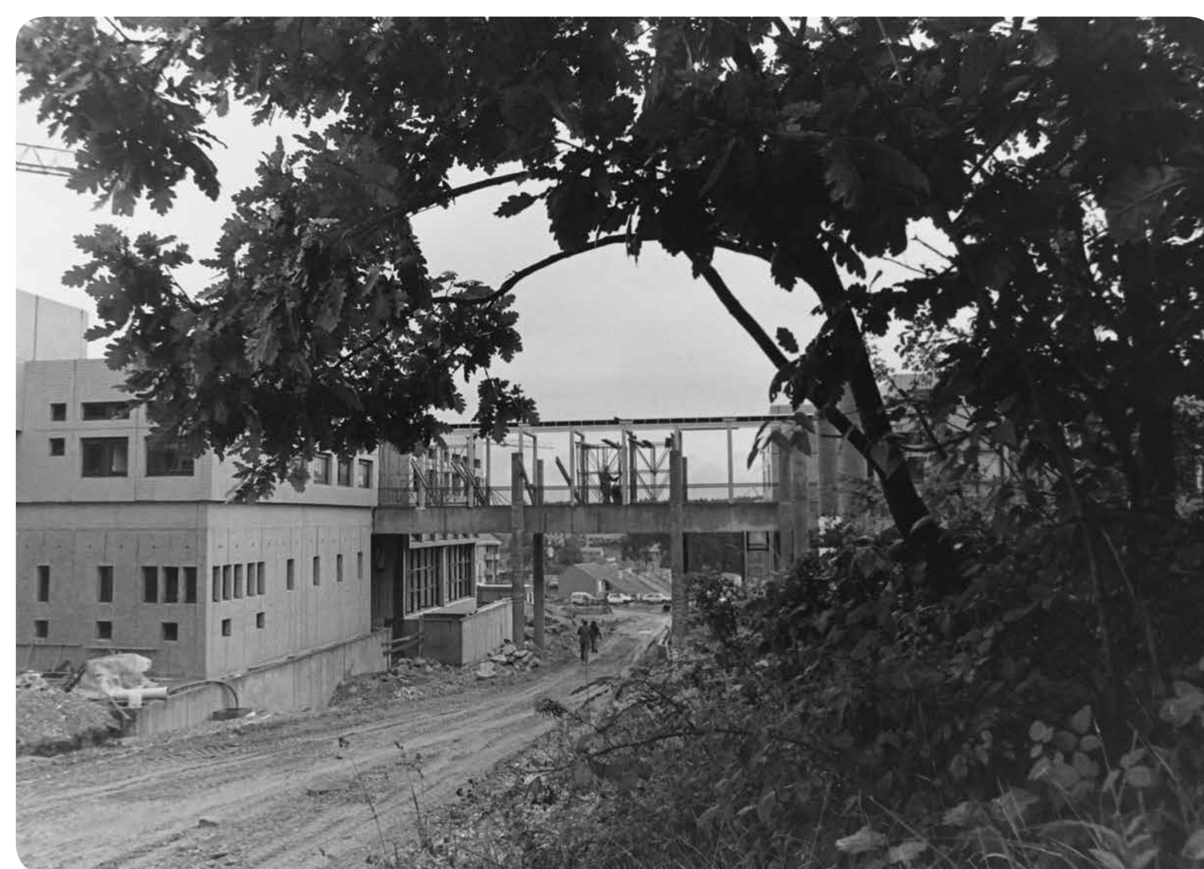
➤ Passerelle Rue Emile Zola
