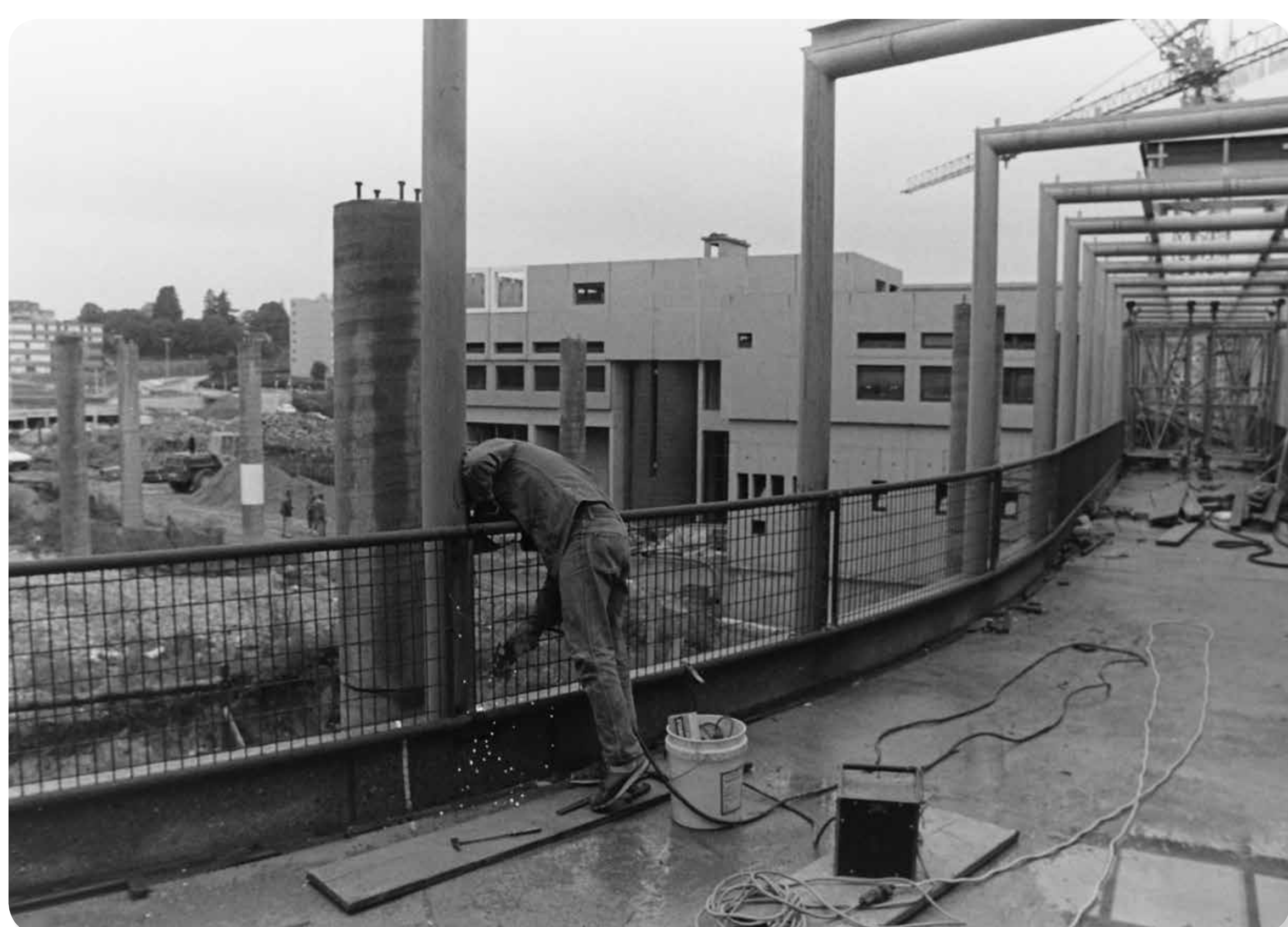
➤ Construction de la passerelle
