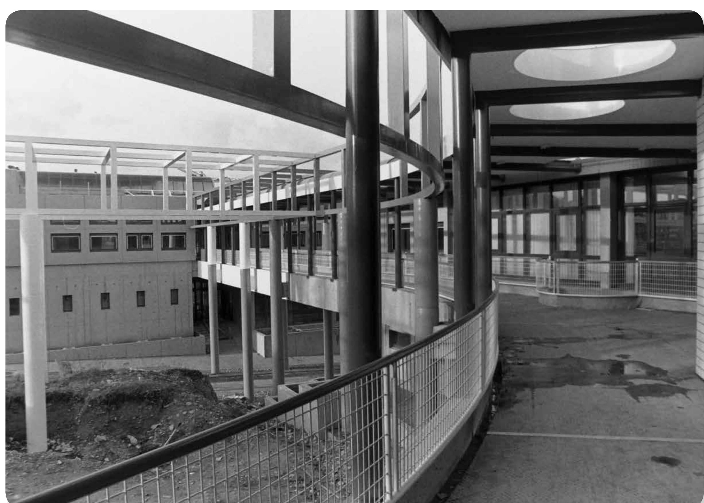
➤ Vue de la passerelle
