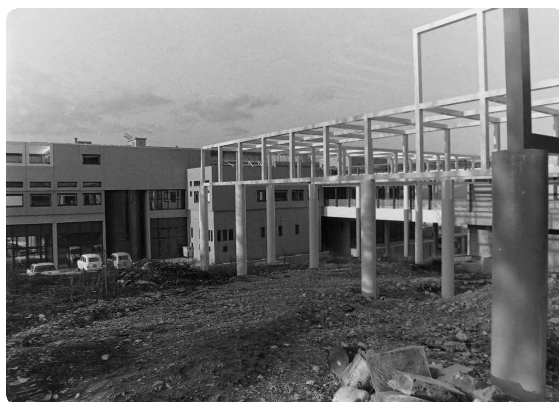
➤ Vue sur la passerelle
