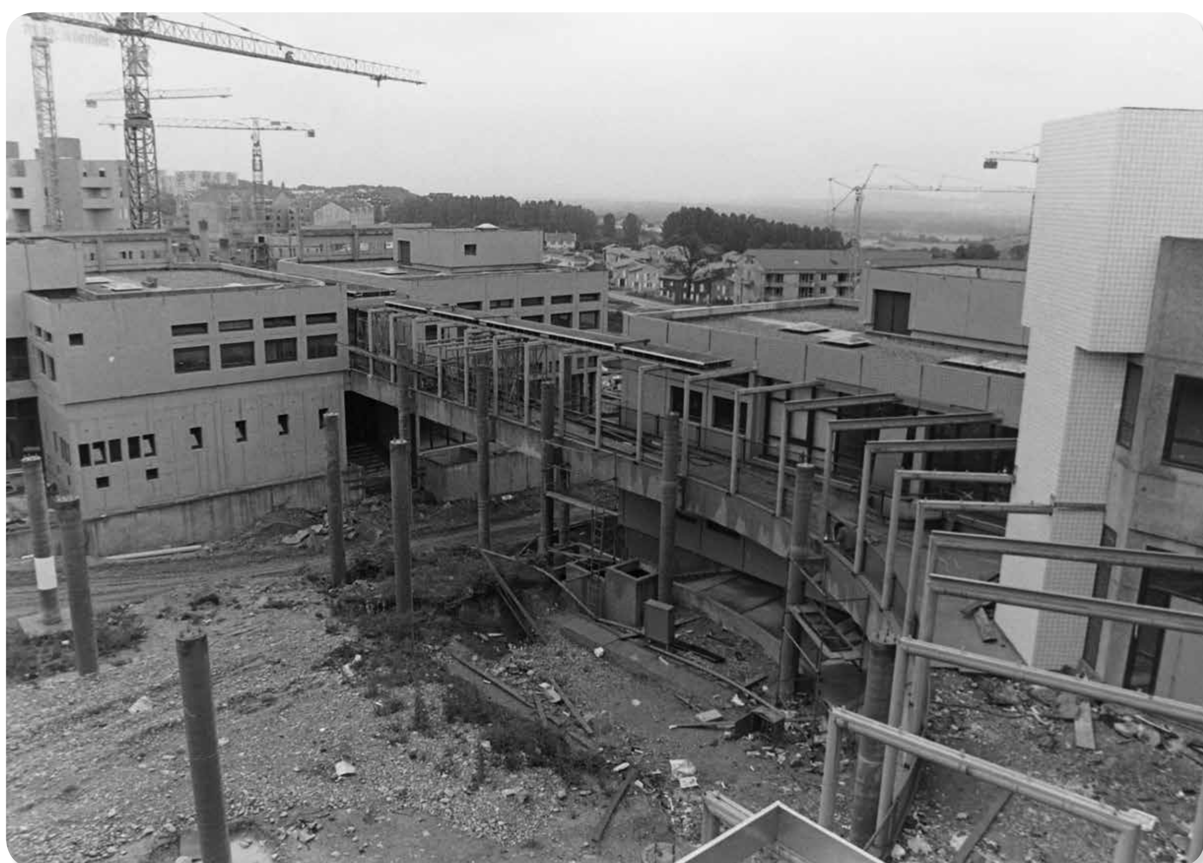
➤ Construction de la passerelle, vue de dessus
